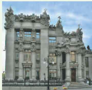
Будинок з химерами. м. Київ. Сучасне фото
