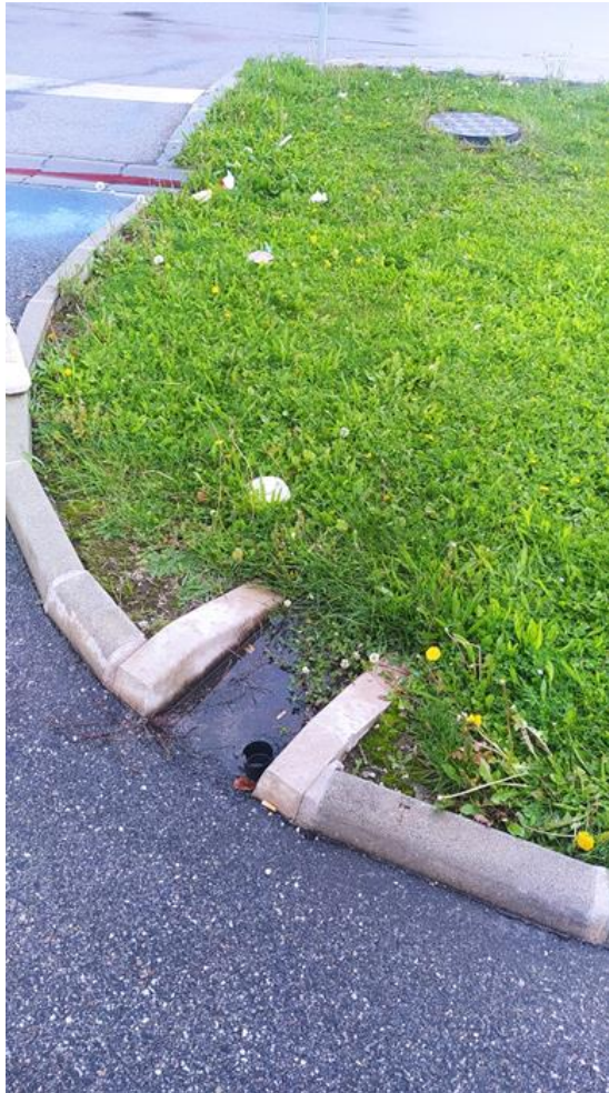
Фото № 5. Просте інженерне рішення для збору дощової води
